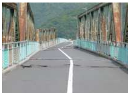
<洗掘による被災例>
