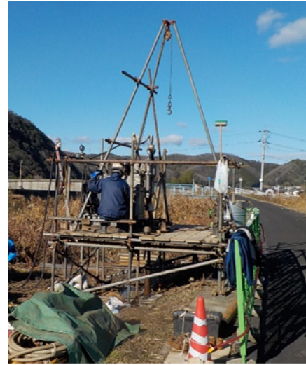
【ボーリング調査状況】
