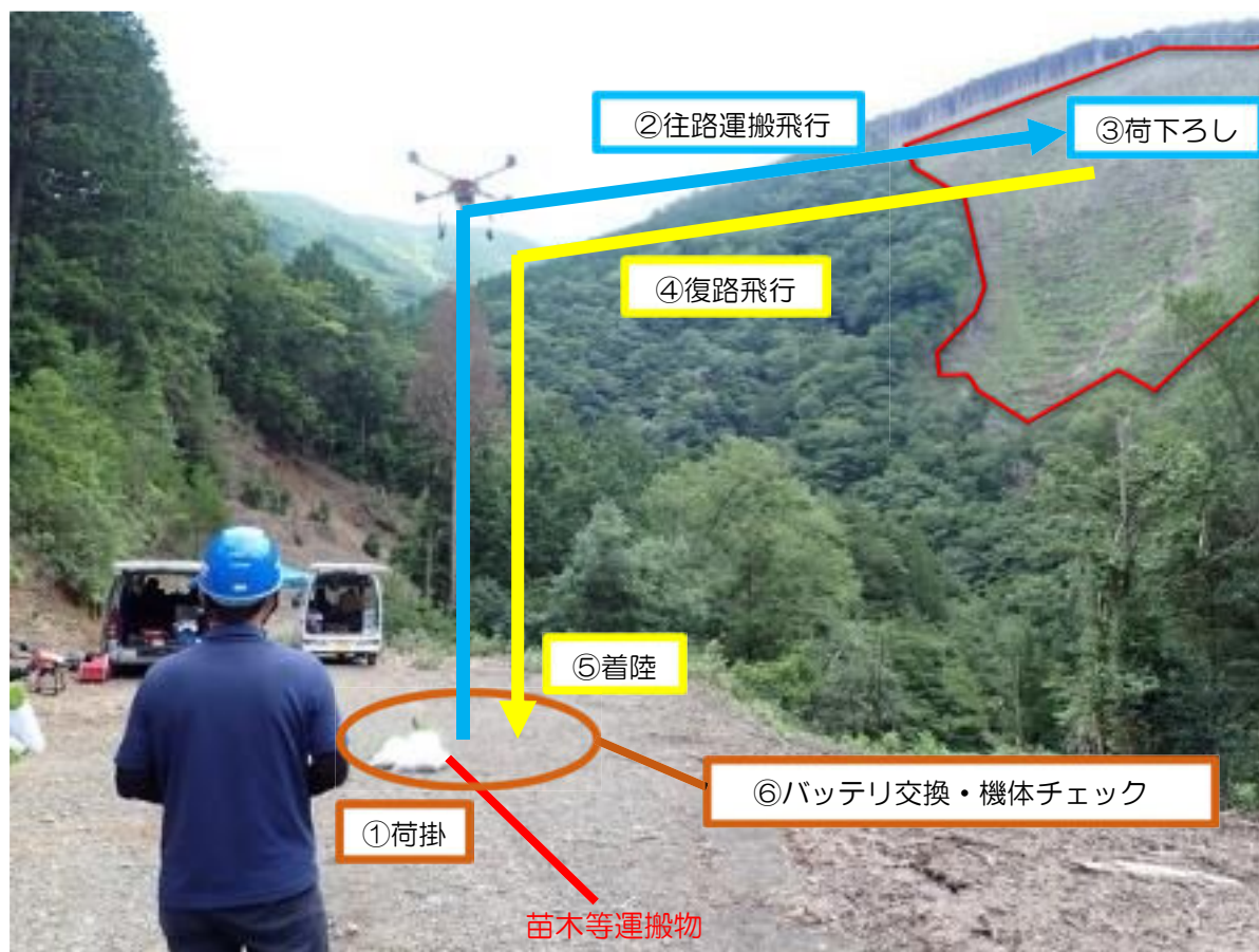
写真 5-3 ドローンによる苗木等運搬における運搬工程（①～⑥）
