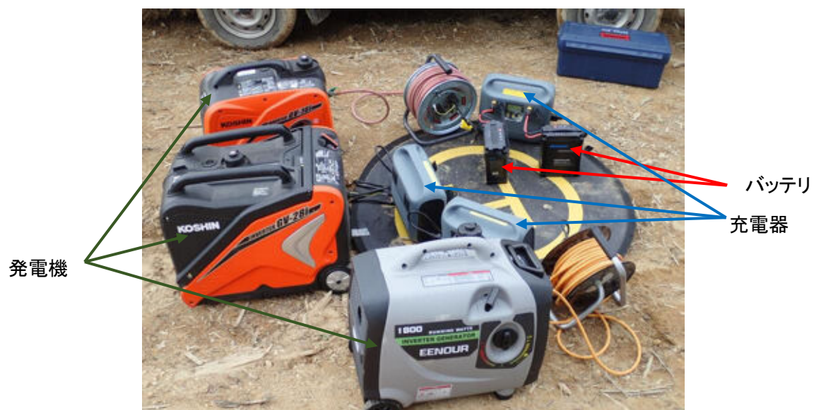
写真 4-6 発電機を充電器につなげ、充電している様子
