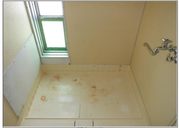
浴槽設置場所
