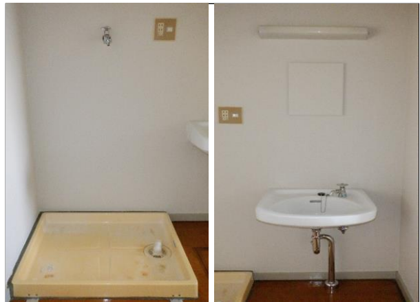
洗濯機置き場
