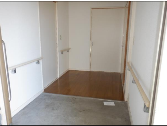
玄関② 玄関内部に手すり有
