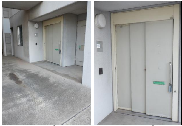
玄関① 玄関(アップ) スロープ、引き戸で車椅子の方も入りやすい仕様。
