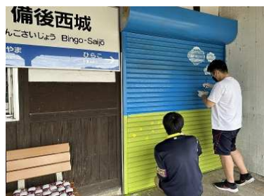
駅舎塗装作業 (西城町観光協会・紫水高校)
