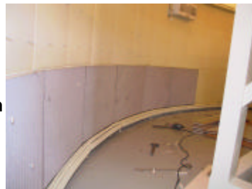
施工中の電波吸収体壁面
