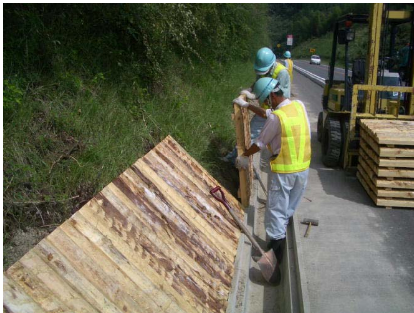
写真4 パネル施工作業の様子
