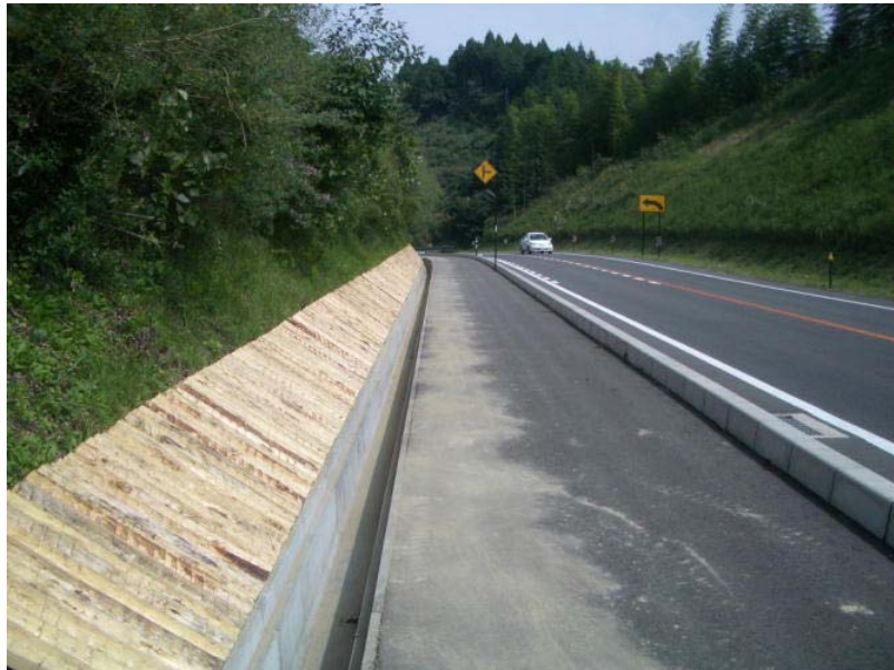
写真1 パネルによる法面被覆現場(向側法面も施工予定)
