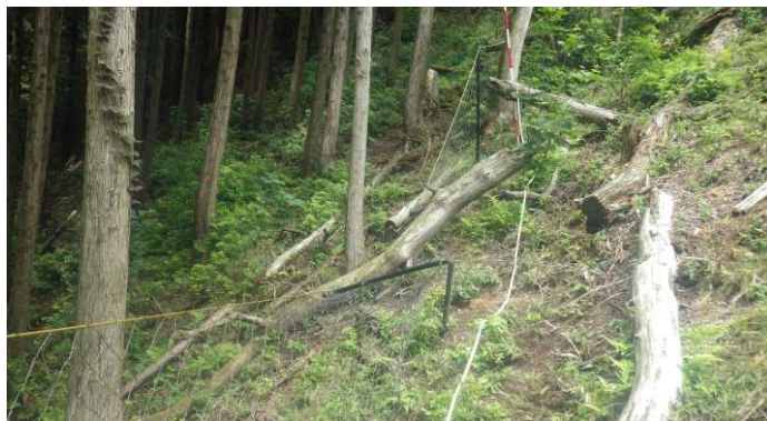
図 - 6 侵入防止柵に発生した破損（倒木落枝）
