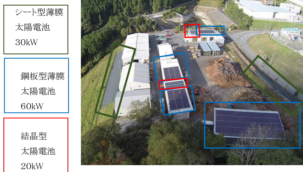
図.V-37 真庭バイオマス集積基地 太陽電池設置状況
