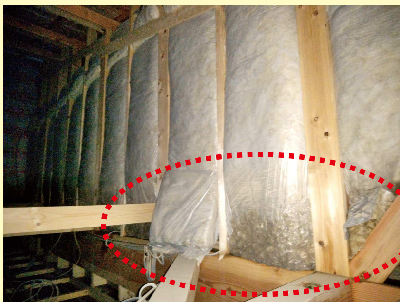
水(泥水)を吸った断熱材
