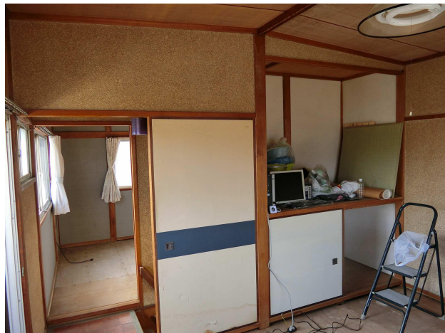
②工事前（2階）
