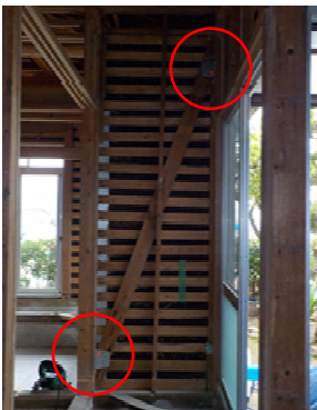
③既設筋交い 金物補強
