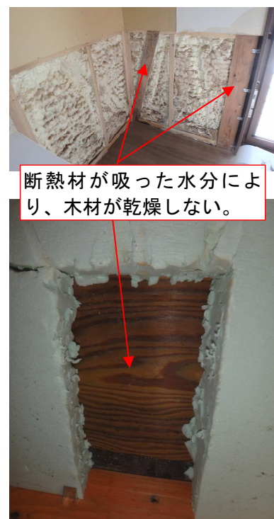
断熱材被害状況
