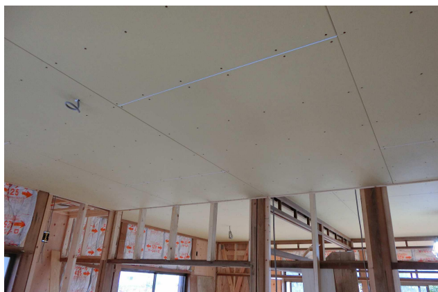
⑧天井下地
