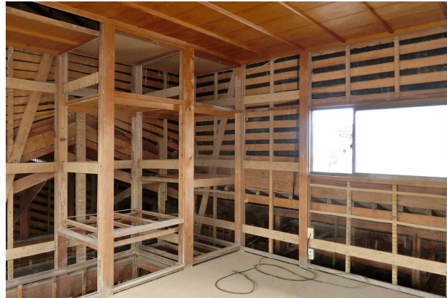
②工事前(2階)
