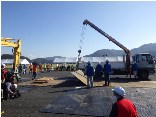
【プログラム①：敷鉄板敷設訓練】
