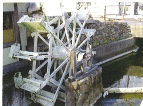
図4 白化した用水路壁と水車
