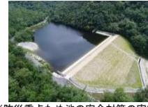
(防災重点ため池の安全対策の実施)
