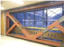
(鉄骨ブレースによる耐震補強)
