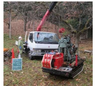
【運搬車による機材搬入】
