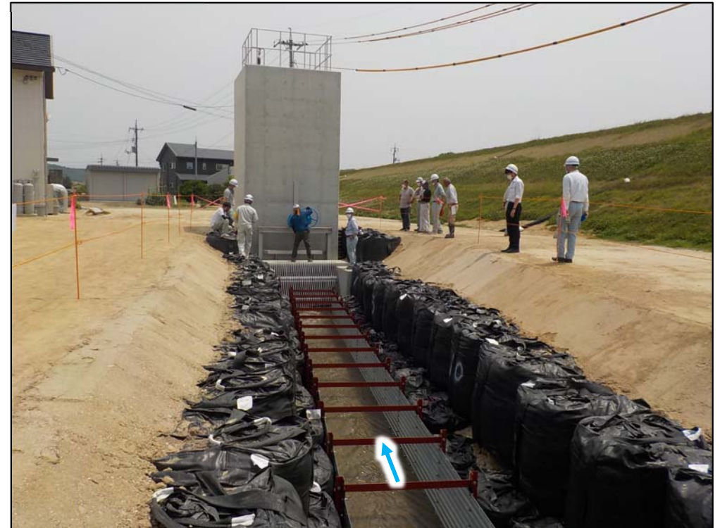
左岸サイホン
