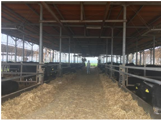
施工前の牛舎内
