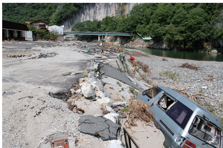
被災から間もない時の井倉洞入り口付近の駐車場。河川の氾濫で路面がめくれ上がっていた＝平成30年7月20日
