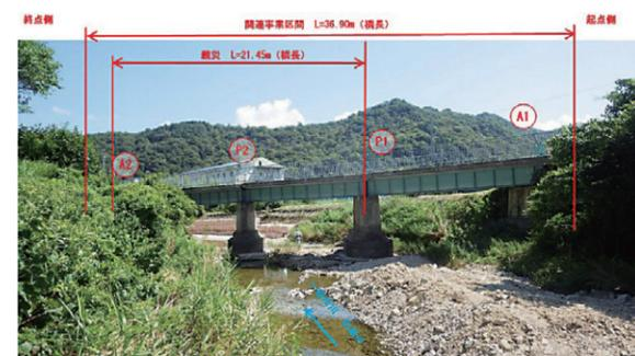
被災状況(橋脚の沈下・傾斜、上部工の変位)
