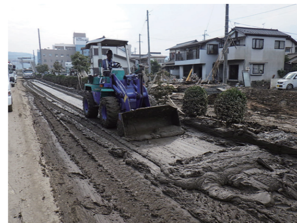
土砂撤去作業状況(倉敷市真備町)
