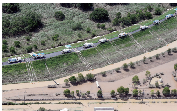
排水活動をするTEC-FORCEのポンプ車（倉敷市真備町）
