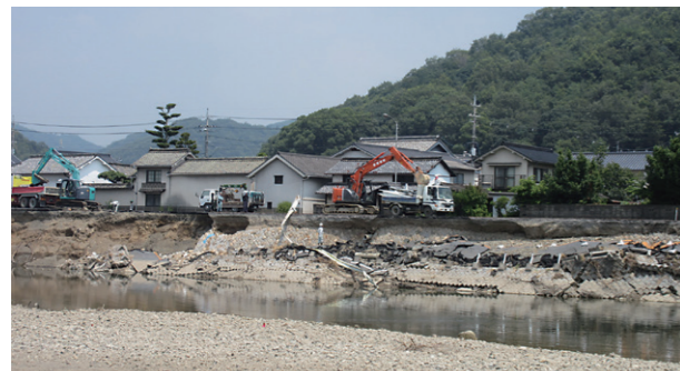
道路兼用護岸の崩壊(井原市西江原町)
