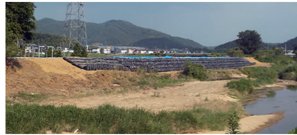
砂川の応急対策後（岡山市）
