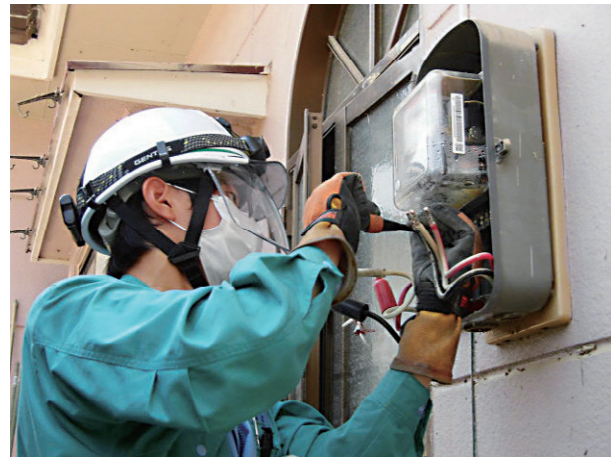
漏電調査・電力量計取り替え
