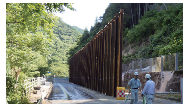
仮設防護柵設置作業（真庭市神代）
