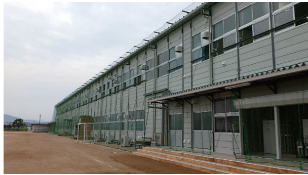
倉敷市立真備東中学校のプレハブ校舎
