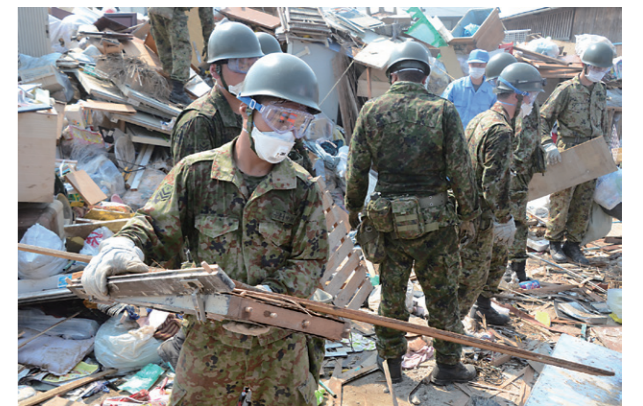
災害廃棄物撤去
