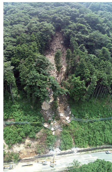
法面崩壊状況（真庭市神代）
