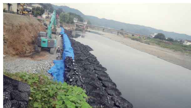
応急復旧の状況(井原市西江原町)
