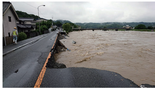
道路兼用護岸の崩壊(井原市西江原町)
