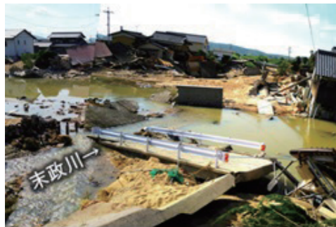
末政川の被災状況及び応急対策後（倉敷市真備町）
