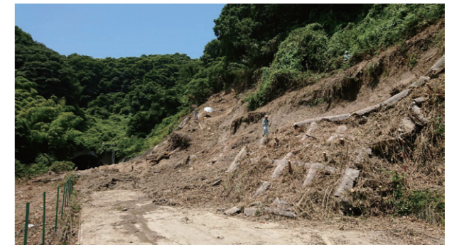
法面保護工破損状況（玉野市滝）
