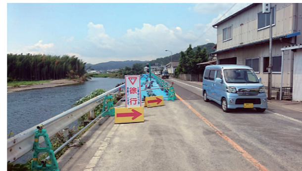
応急復旧の状況(井原市西江原町)
