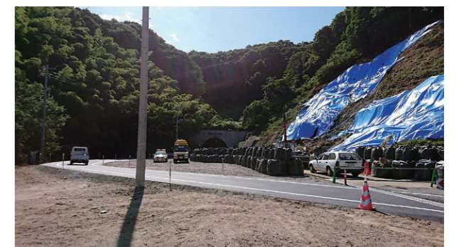
応急復旧の状況（玉野市滝）
