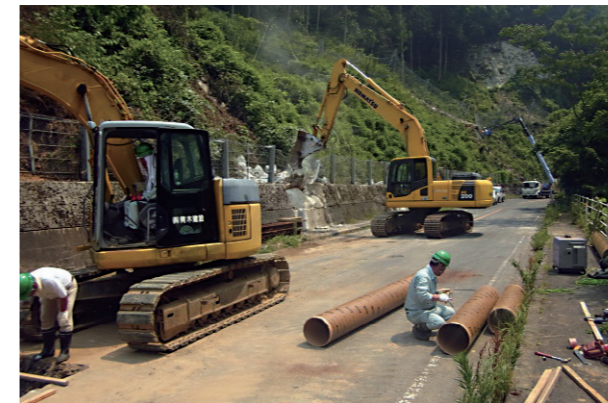
仮設防護柵設置作業（真庭市神代）
