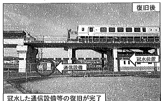
冠水した通信設備等の復旧が完了
