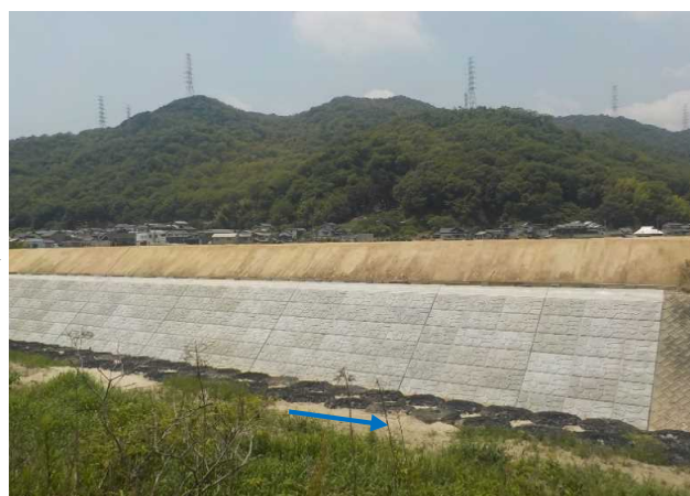
原形復旧完了 (R1.6.5)
