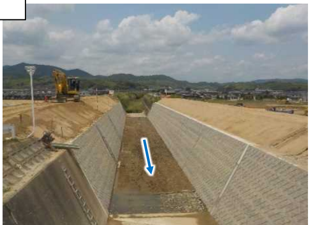
原形復旧完了 (R1.6.10)
