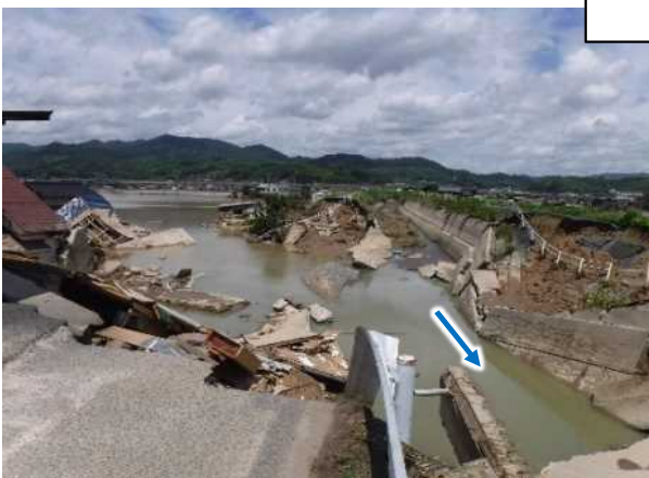
被災時状況 (H30.7.10)
