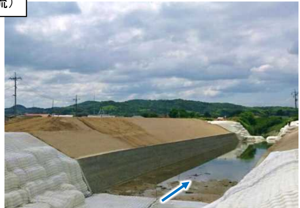
原形復旧完了 (R1.6.12)
