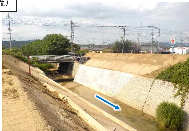
原形復旧完了 (R1.6.11)
