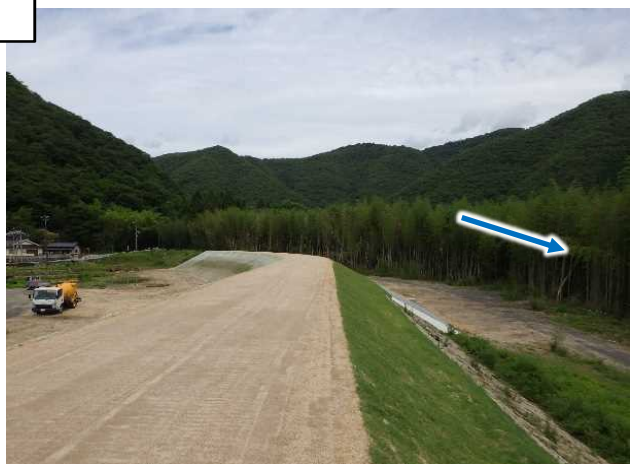
改良復旧完了 (R1.6.24 撮影)
