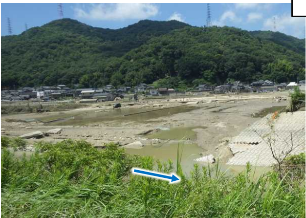
被災時状況 (H30.7.10 撮影)
