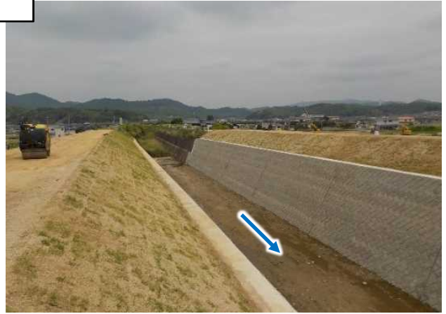
改良復旧完了 (R1.6.26 撮影)
