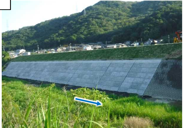
改良復旧完了 (R1.6.25 撮影)
