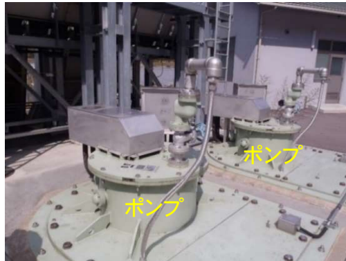
[和気町佐伯地区の排水機(ポンプ)、美岡だより第1号で紹介した事例]
