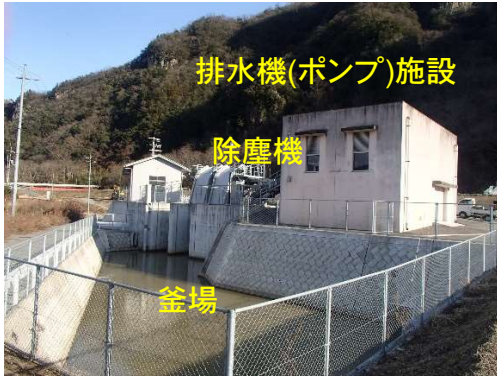
[和気町佐伯地区の排水機(ポンプ)、美岡だより第1号で紹介した事例]
