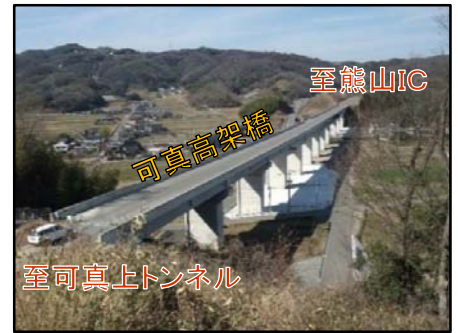
③熊山IC付近 可真高架橋
