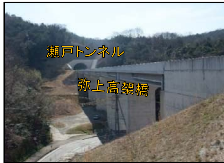
②瀬戸トンネル坑口及び弥上高架橋
