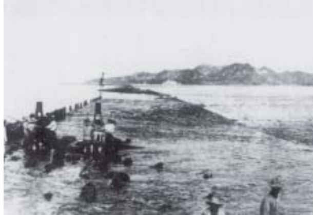
当時の干拓潮止め堤防工事の様子 海の中に堤防を築く大変な難工事だった。 向こう側に見える山は、児島半島です。 (写真提供：国土交通省 岡山国道事務所「岡山道物語」)
