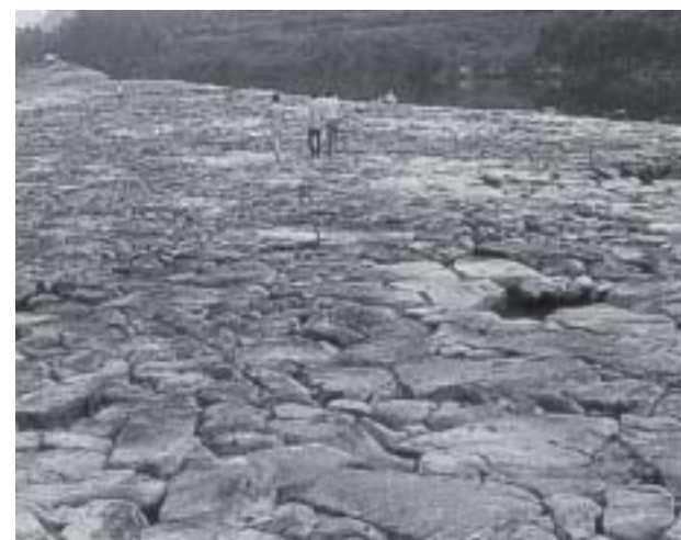
石で造られた田原井堰
