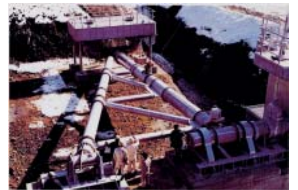
フローティングアーム 写真上部の四角い部分が水に浮き、そこから水をとる
