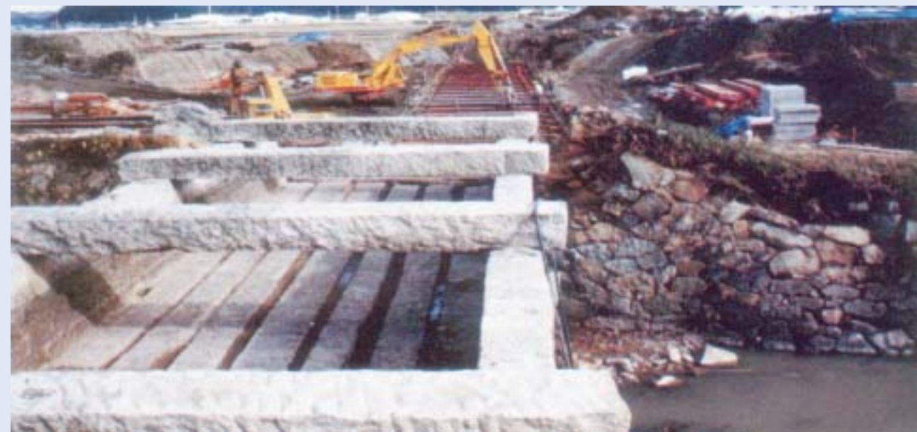
動かされる前の「石の掛樋」（1982年頃） 現在の田原用水は、小野田川の下を通っています。
