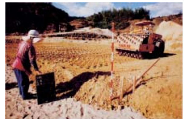
タンピングローラー いぼいぼの部分が、千本づきの役割をもっている
