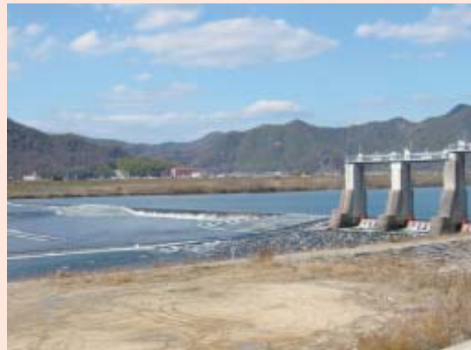
コンクリートで造った堰
