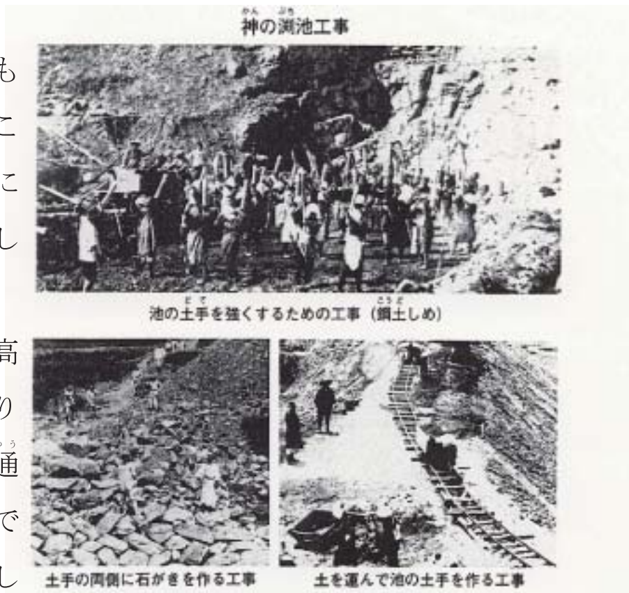
当時の工事の様子
