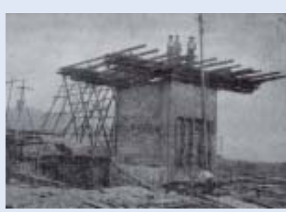
島の上で沈めるための筒を造ります
