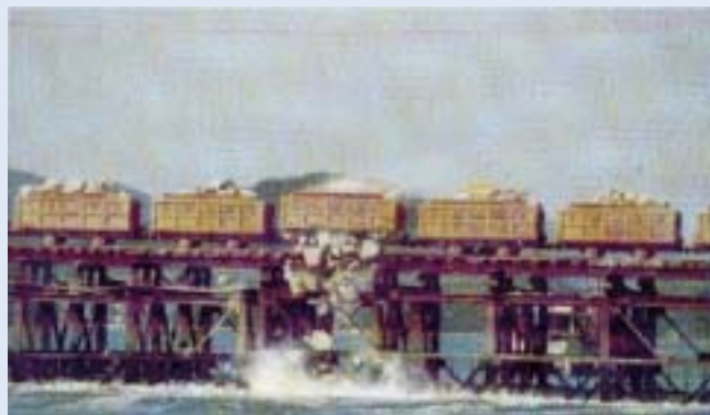
海の上にレールを敷き、捨て石を行いました
