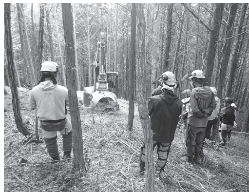
外部講師によるヘアピンカーブの施工デモ
