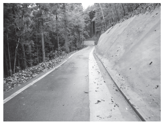
法面保護工の改良
