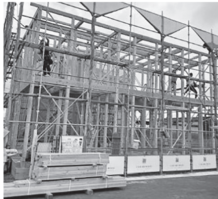
県産森林認証材を用いて建築中の住宅
