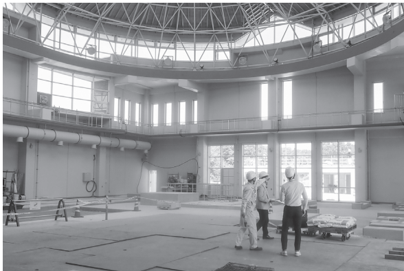
建設中の高梁バイオマス発電所
