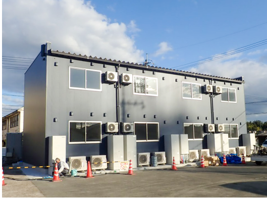
建築中の沼自動車学校木造宿泊棟
