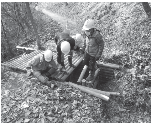
福山遊歩道補修状況
