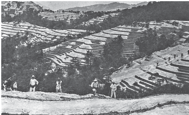
池田村槇谷地内の砂防工事(T6施行中)
