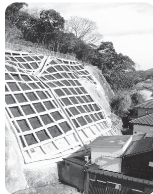
〔山腹工（法枠工）〕
