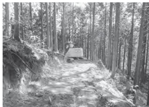
林地残材搬出作業道の作設状況 (500円/m助成)
