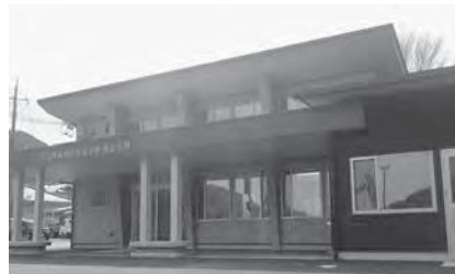
①岡山県森林組合連合会勝山支所 (木造化施設・一部CLT使用)
