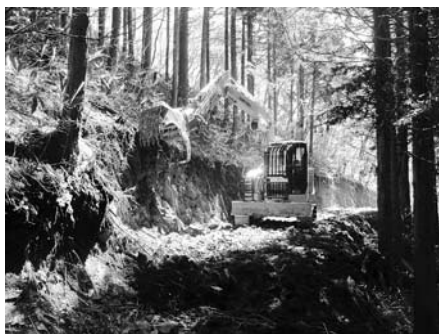
作業道作設の様子 (新見市千屋実地内)
