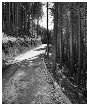
作設した作業道。盛土側に丸太組を設置している。 (新見市千屋実地内)
