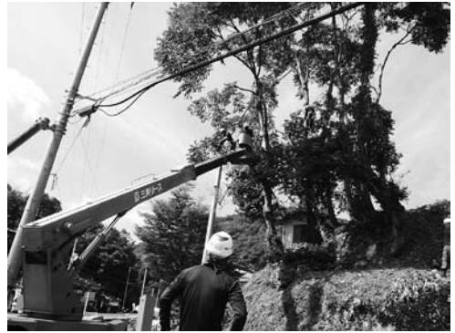
高所作業車による伐採作業 山科社長(手前)が細かく指示を出します
