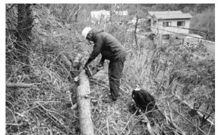
松くい虫被害木の伐倒による駆除
