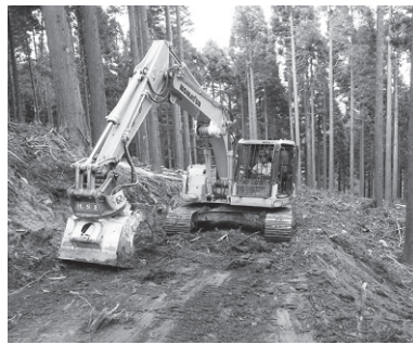
作業道の作設状況
