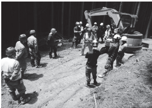
森林作業道作設オペレーター育成研修
