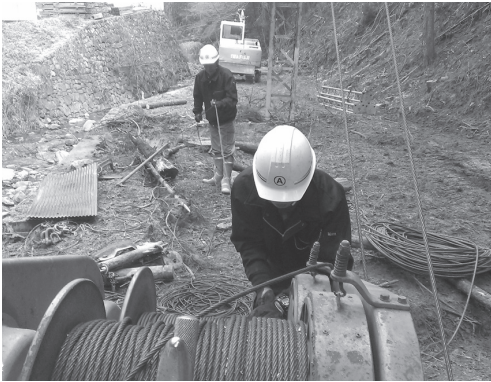
集材機設置の様子
