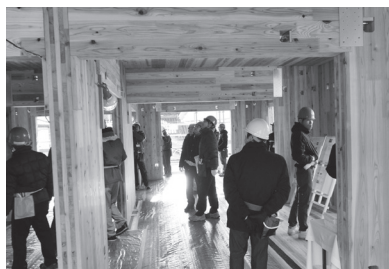
CLT住宅構造見学会 （建物内部の状況）
