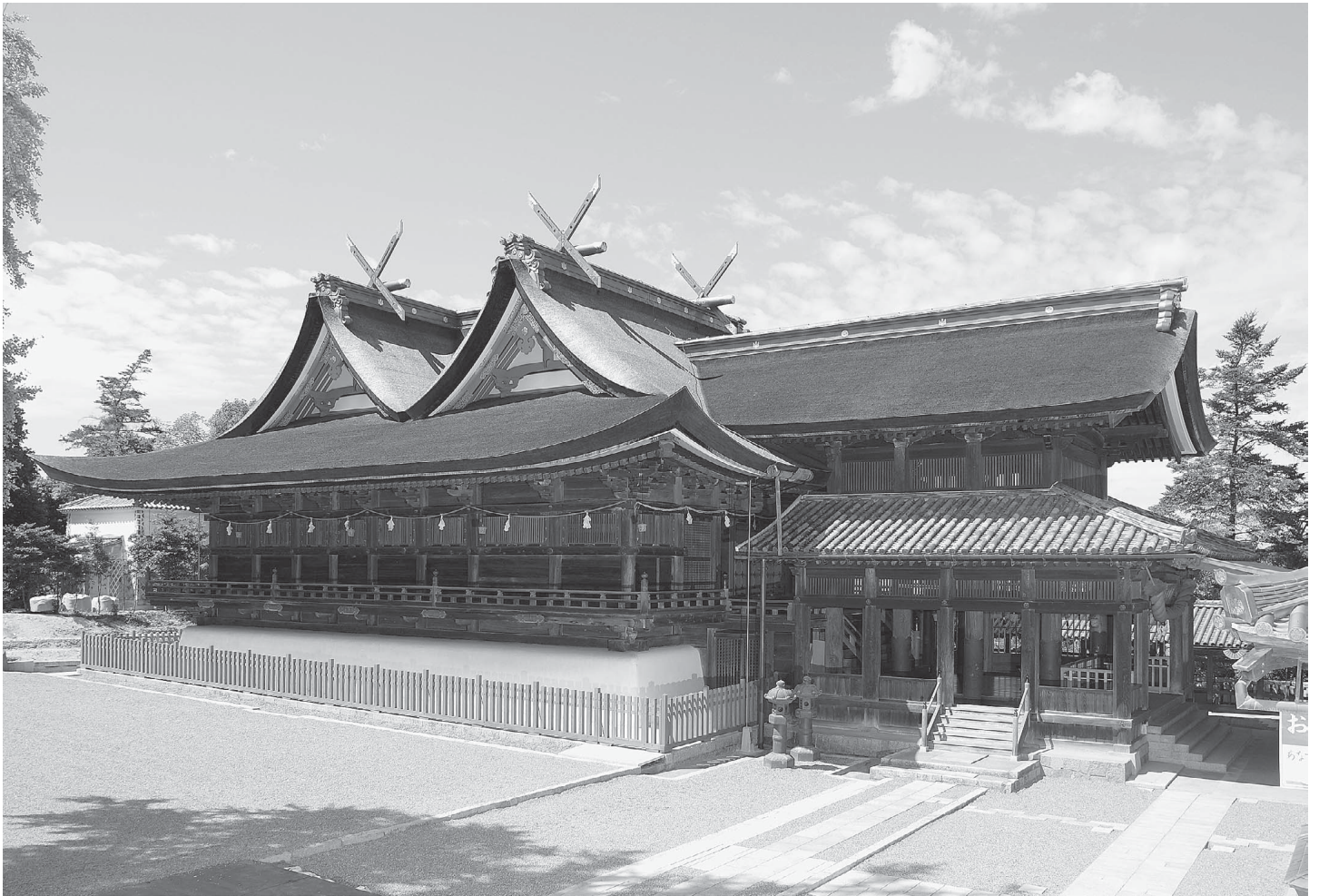
保存修理工事の完了した国宝吉備津神社本殿及び拝殿（岡山市吉備津）
