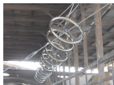
図2 十分な台数の換気扇を設置
