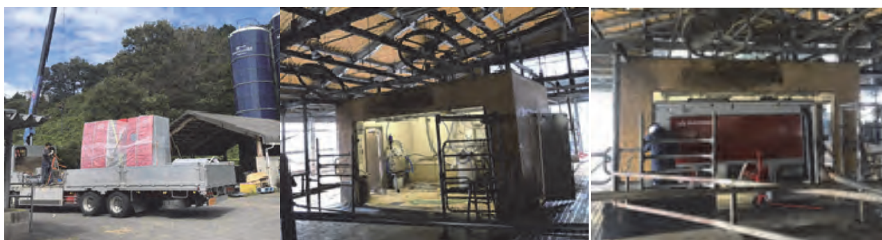
写真2 搾乳ロボット到着から設置まで
