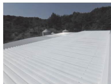
図3 屋根の断熱塗装
