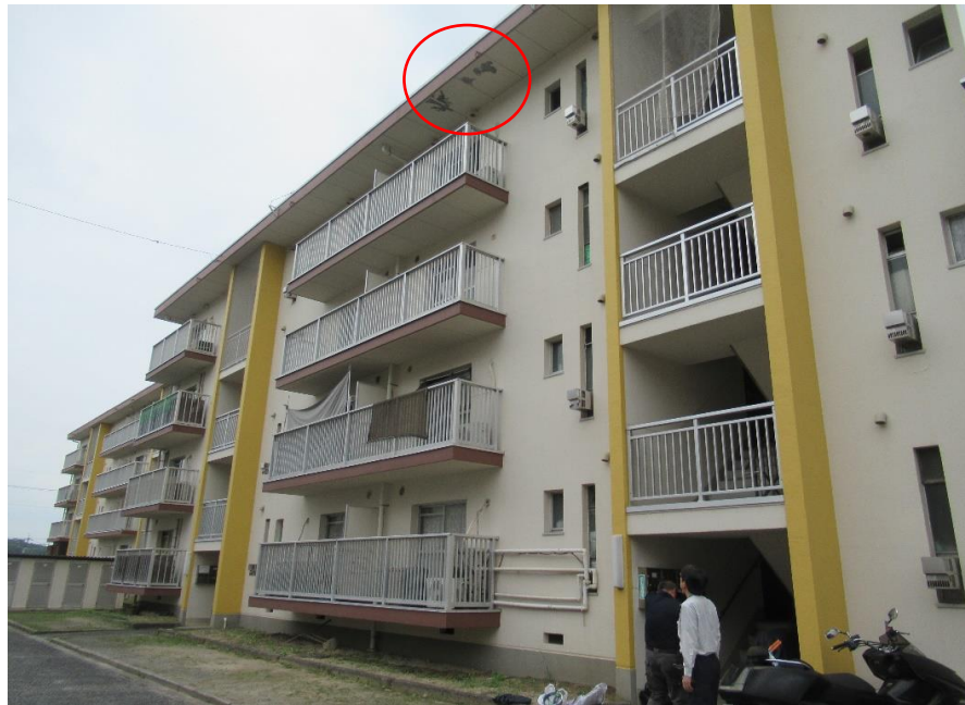
県営住宅総社泉団地 2号棟 北面
