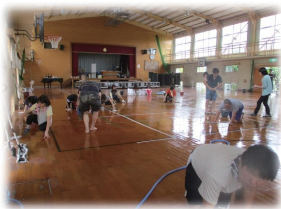
【西日本豪雨災害による体育館復旧作業】 緊急配信メールで駆けつけた保護者と教職員で2018年7月7日の朝、床上浸水した体育館の洗浄を行いました。
