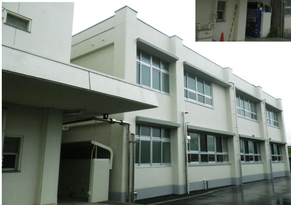
【建物外観(工事後)】
