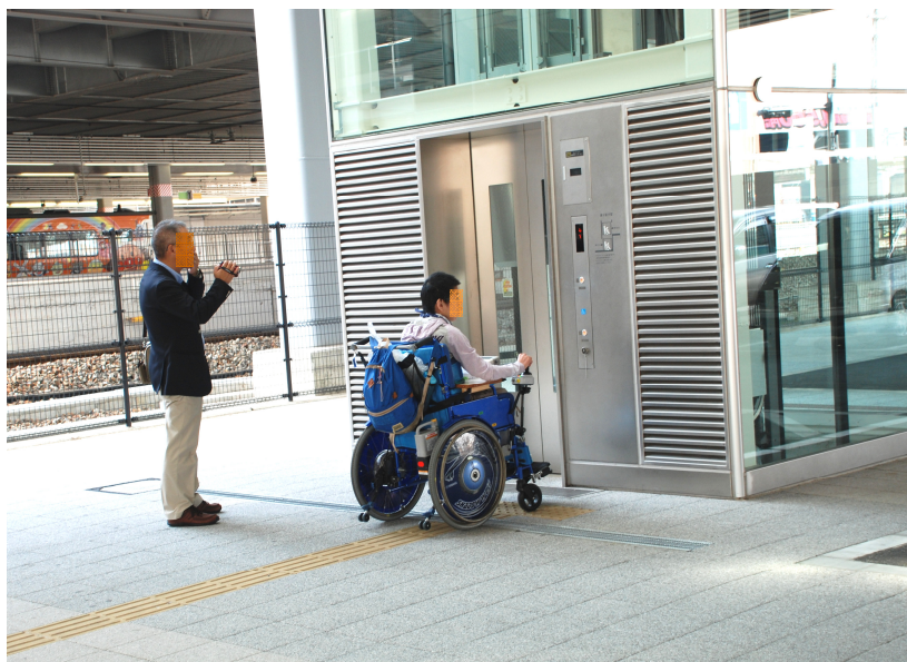
エレベーター
